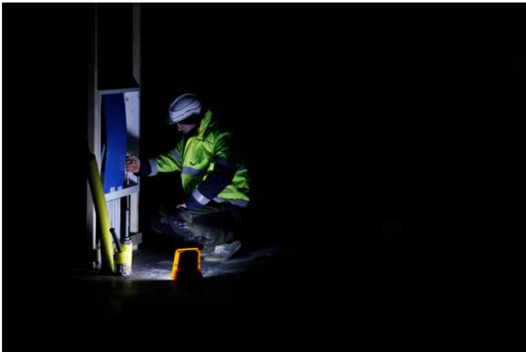
Snabbt servicearbete utan att behöva hitta strömkabel, med uppladdningsbara Magnum 20W art.nr 553521 med 2-6 timmars drifttid beroende på vald ljusstyrka.
